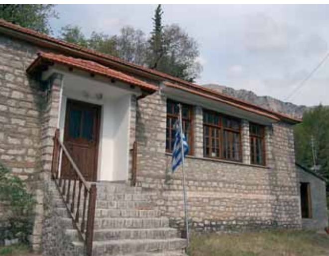
Πετρωτό: Το νέο σχολείο.
